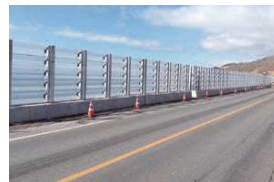
一般国道336号えりも町
