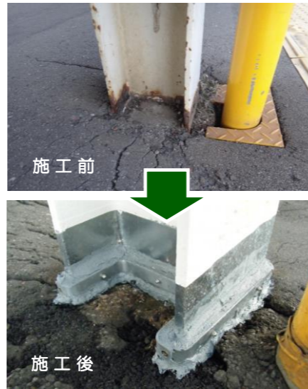
融雪剤使用環境の駅舎支柱
