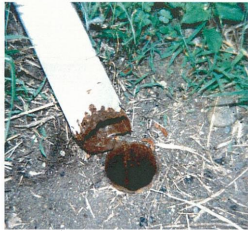
地際腐食により折れた支柱
