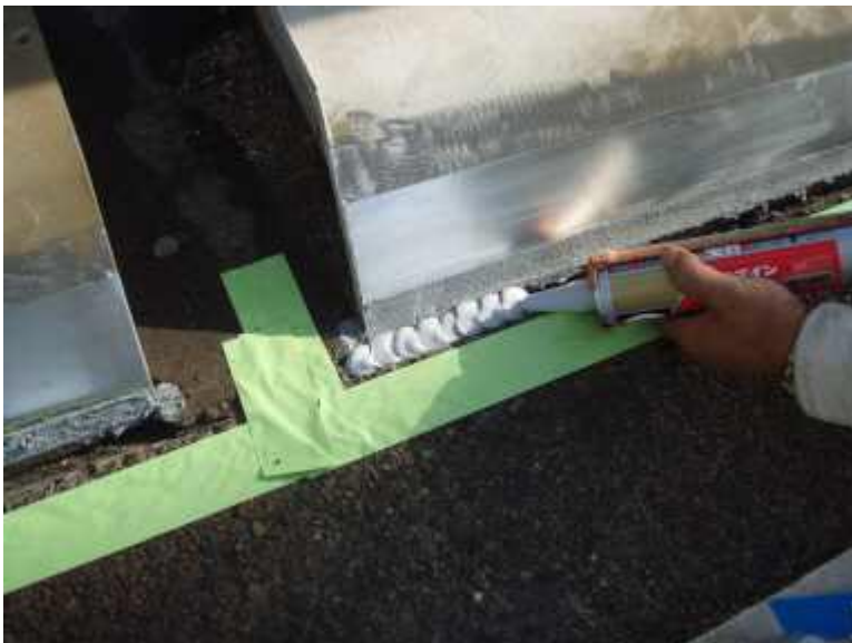
隙間にメタルガードソリッドを充填
