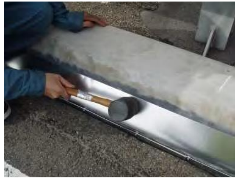
メタルガードテープ貼り付け
