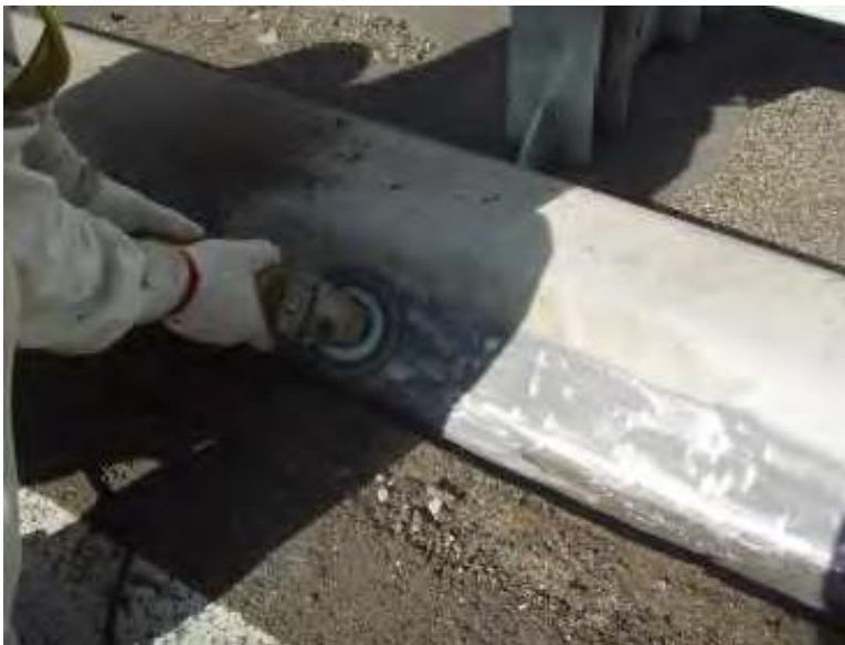
サンダーにより下地処理
